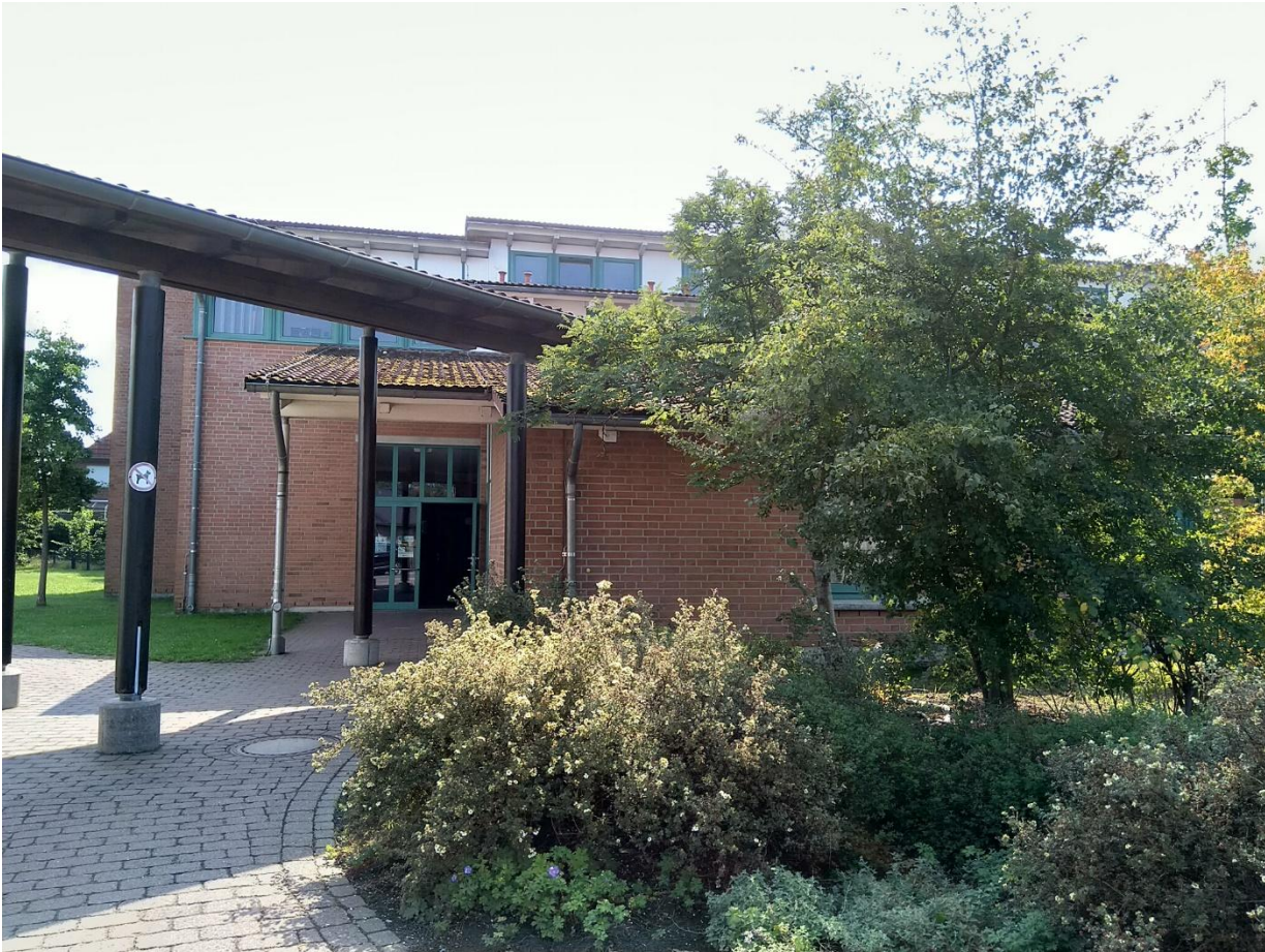
Ansicht Eingang Nord – von Klosterstraße
