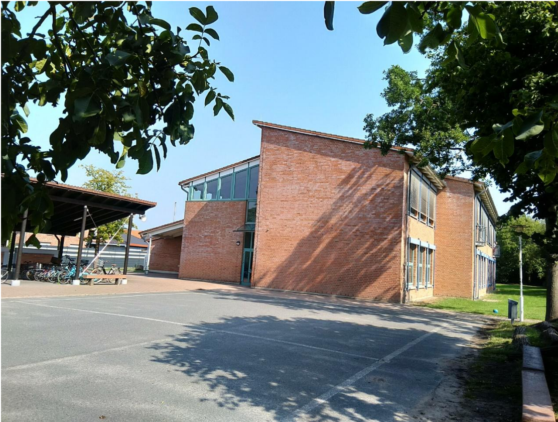
Ansicht von Schulhof Giebelseite Süd
